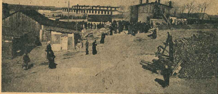
Pożar nowej elektrowni — rok 1934
