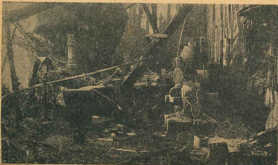
Wnętrze spalonej elektrowni
